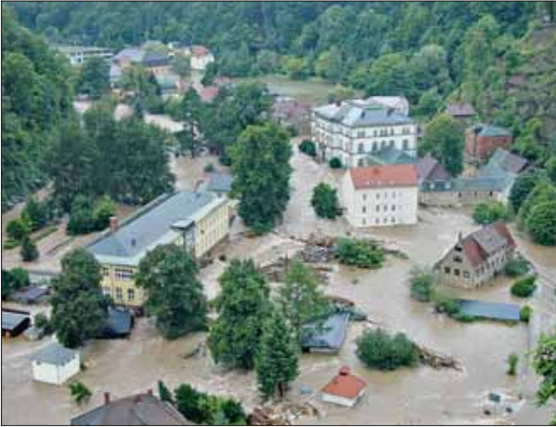
Die Flut der Wilden Weißeritz im August 2002 verursachte am Hochschulstandort Tharandt massive Schäden. Foto: Jenny Kiesling
